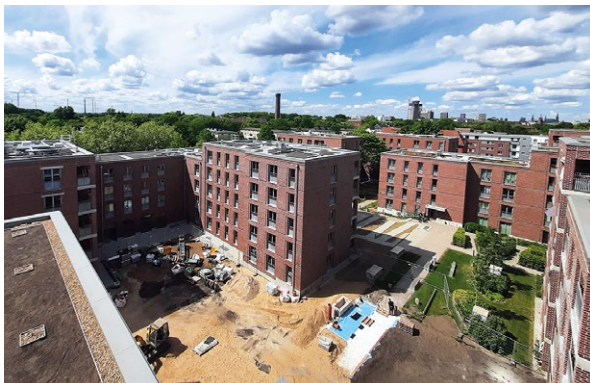
Ein Großprojekt mit mehreren Bauabschnitten – vier von sechs sind bereits vollendet.
