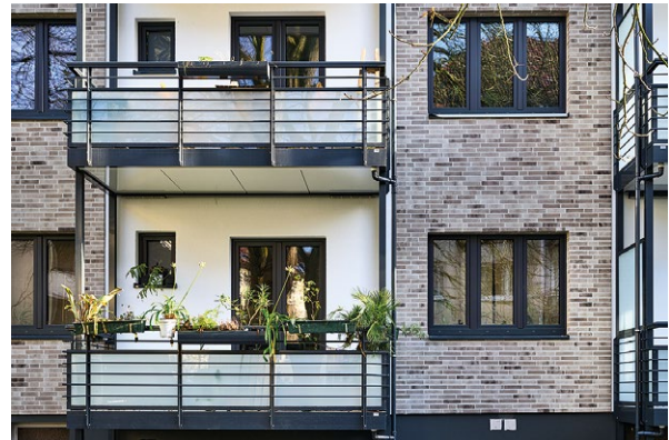
Die Backsteinoptik der Fassade konnte bei der Modernisierung erhalten bleiben.
