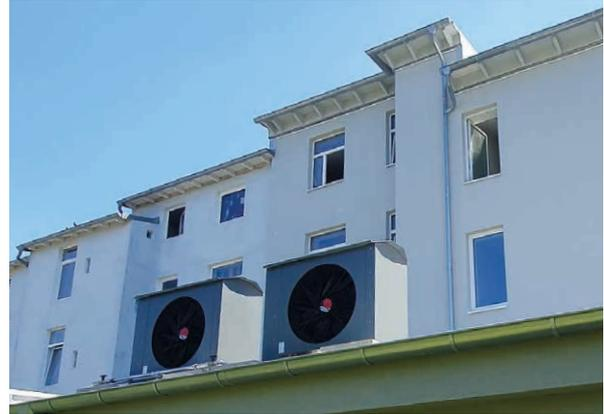
Die Luft-Wasser-Wärmepumpe liefert Heizungsenergie und dient zur Warmwasserbereitung.
