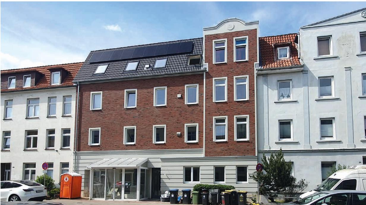
Neue Fenster und Türen, Dämmung für die Gebäudehülle und das Dach und der Umstieg auf erneuerbare Energien – innerhalb eines Jahres wurde das Gebäude zu einem Effizienzhaus 40.
