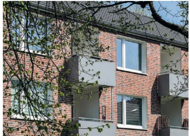
Bei der Fassadenmodernisierung blieb das ursprüngliche Erscheinungsbild durch die Verwendung von Klinkerriemchen erhalten.
