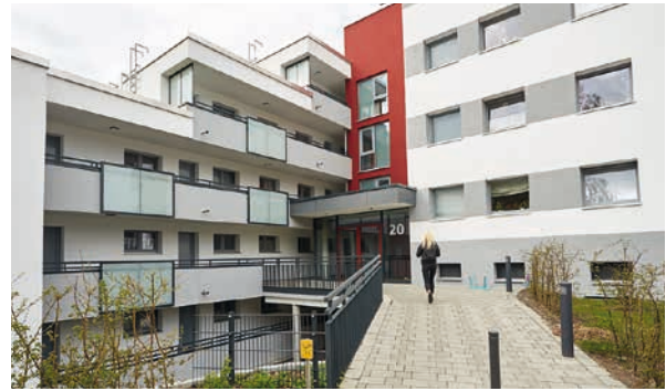
Nach dem Umbau: Durch den ebenerdigen Eingang ist der Bereich offen, freundlich und barrierefrei
