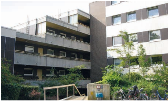
Vor der Modernisierung: Eine Treppe führt zum dunklen Hauseingang im Tiefparterre
